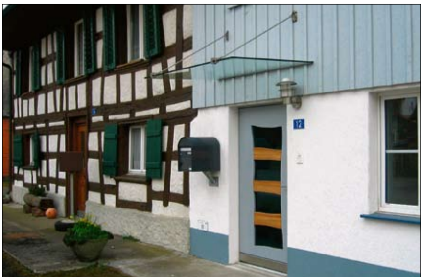
Modernes Glasvordach, geliefert und montiert von Marcel Sonderegger.
